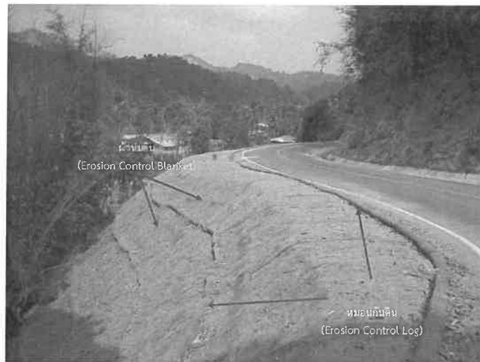
รูปที่ 21 ตัวอย่างผ้าห่มดินและหมอนกันดิน ในพื้นที่ลาดเชิงเขา (ข้อ 4.1.5.5)
