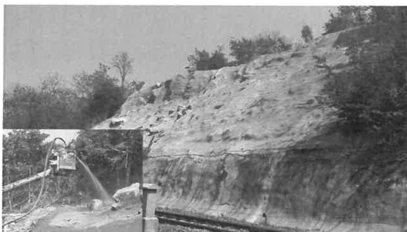
รูปที่ 24 ตัวอย่างการฉีดพ่นคอนกรีต (shotcrete)
