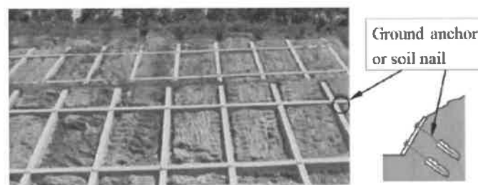
รูปที่ 23 การทำ grid beam ร่วมกับ soil nail
