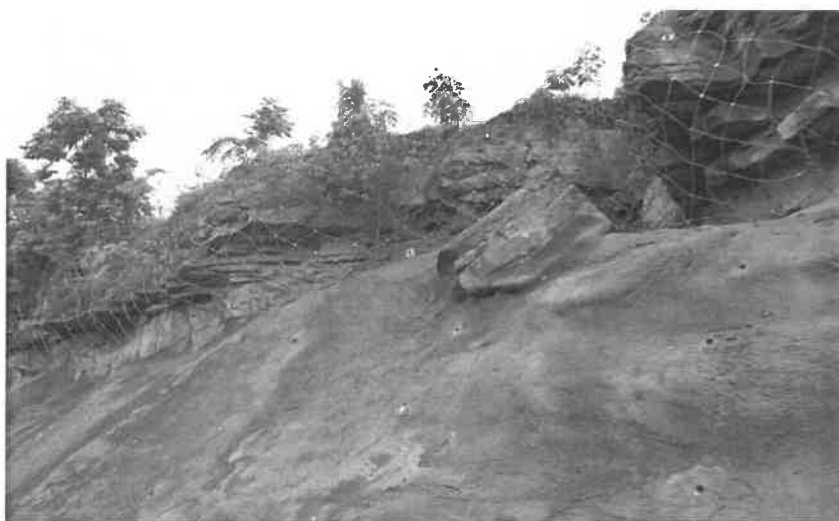
รูปที่ 35 ตัวอย่างการป้องกันหินร่วงด้วยวิธี high strength netting ร่วมกับ shotcrete
